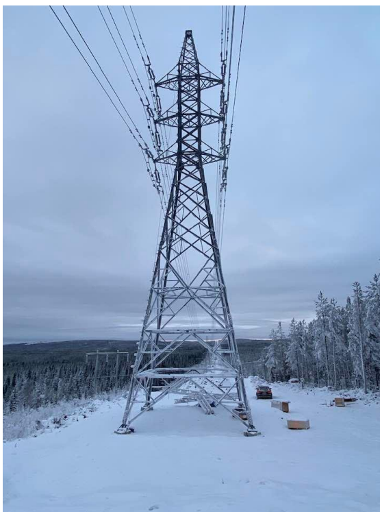
Figur 13. Exempelbild föreställande en enkelstolpe i stål. Observera att bilden visar en stolpe med duplex-linor. I aktuellt projekt kommer enbart en lina per fas att användas.
