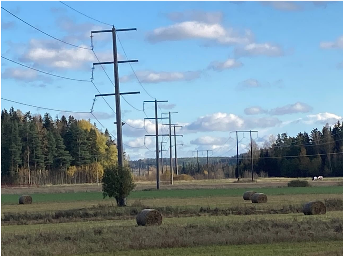
Figur 10. Ledningen i vänstra delen av fotot är L10 där nya ledningen kan sambyggas på befintliga betongstolpar. Ledning OL8 syns till höger i bild.
